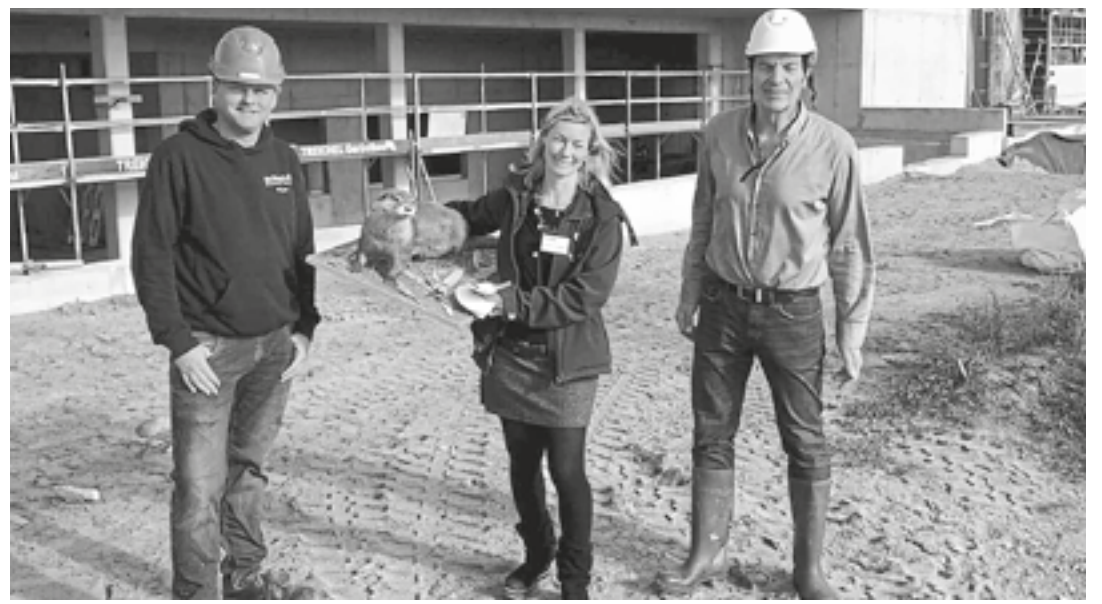
Sind zufrieden mit dem Baufortschritt der Otteranlage: Projektleiterin Marén Bökamp-Hamkens (mi.), Multimar-Leiter Gerd Meurs-Scher (re.) und Bauleiter Nils Tolk.
